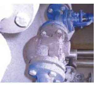
蒸汽排水器檢測
